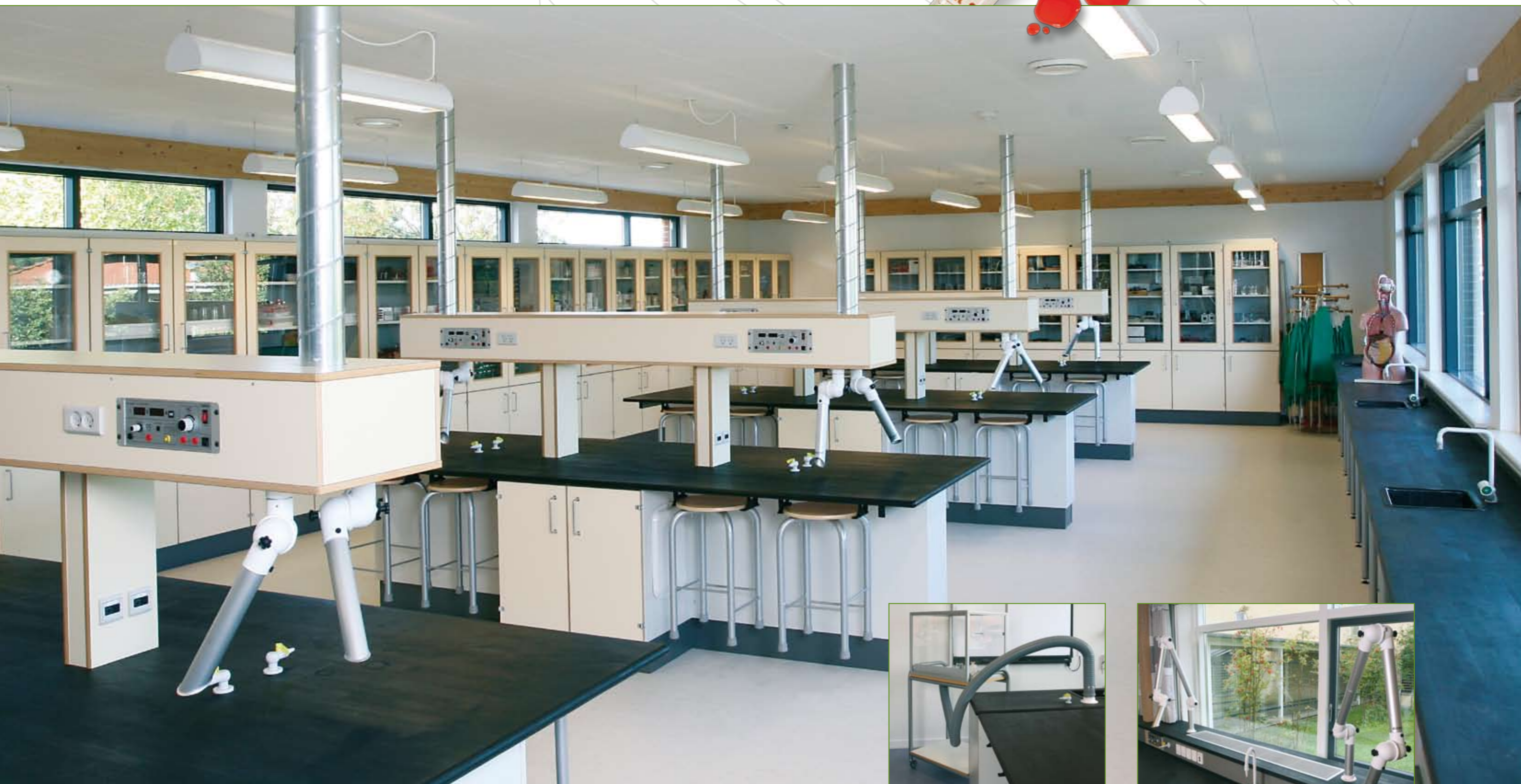
▲ Mobilt aftrækskab giver mulighed for sikker udførelse af mere "eksplosive" forsøg. Tilkobles til eksisterende procesventilation.
